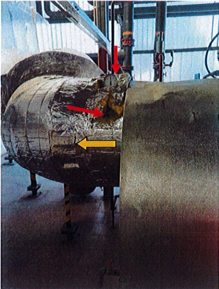
Obrázok č. 1 Kotel K3 - vyznačenie meracieho miesta a smer prúdenia spalín
